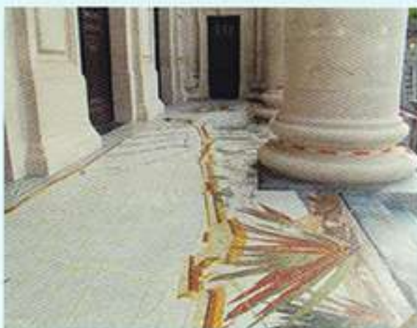
Vue de fin de chantier © KMSKA & Marie Zolamian
